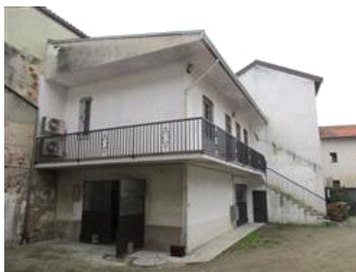
corpo di fabbrica in cortile
